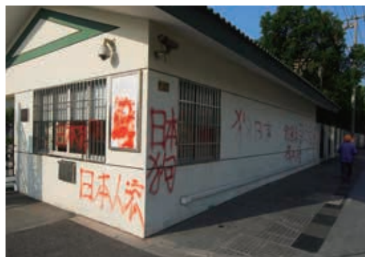
【日本人学校警備室への落書きの状況】
