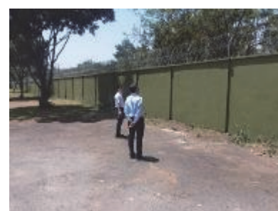
東西の新設壁と侵入防止ワイヤー
