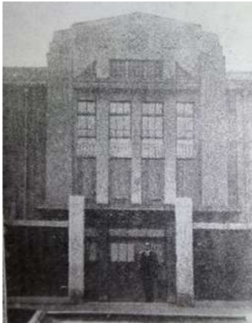
図9 猿江小学校の鉄筋コンクリート校舎
