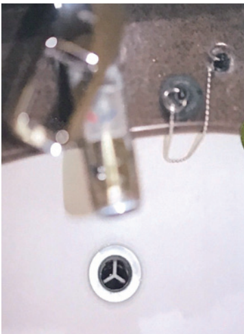
図9 洗面台の排水口
