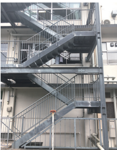
図12 建物の外階段
