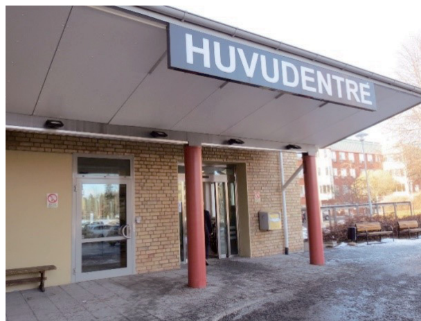
写真8 ボーレンゲのハビリテーションセンターの外観
