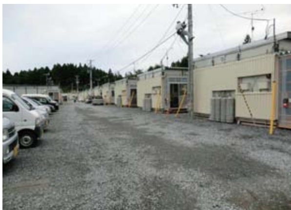
第一中学校の校庭に建設された仮設住宅
